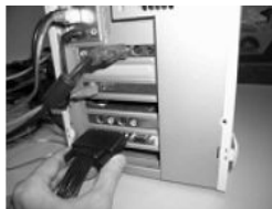
Рис. 2—2 Монтаж интерфейсного кабеля
